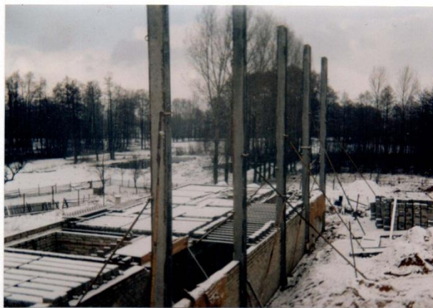
Zimowa przerwa na budowie.
