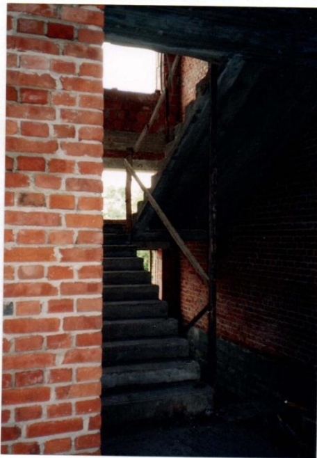
Fragment klattki schodowej.
