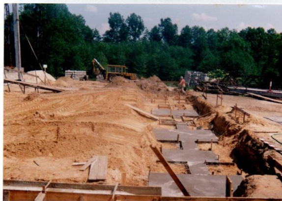
Lalane fundamenty pod następne stupy nosne sali gimnastycznej.
