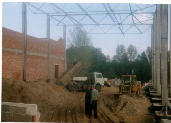
Dyr. szkoły J. Wąch na terenie budowy.
