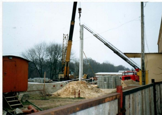
Stawianie pierwszego słupa nośnego.
