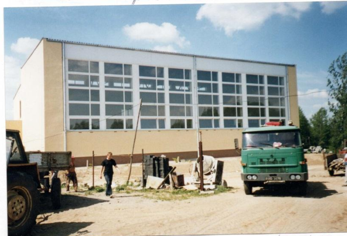
Trwają prace porządkowe wokół szkoły.
