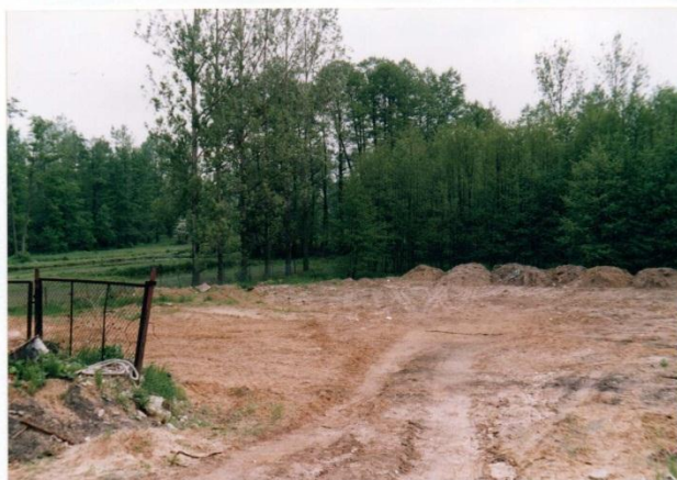
Widok na przyszłe boisko. Trwa równanie terenu.
